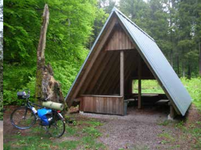
Neu gebaute Schutzhütte
